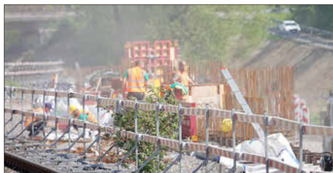
Noch verhindert eine Baustelle bei Heimersheim die Zweigleisigkeit. Das geht wohl noch das ganze Jahr über so. Foto: Weber
