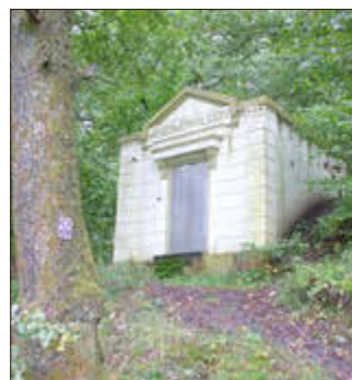
Der Alsdorfer Hochbehälter aus den 1910er-Jahren (2010). Foto: Gerd Bäumer
