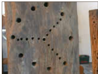
Niströhren gebohrt in einen Eichenbalken
