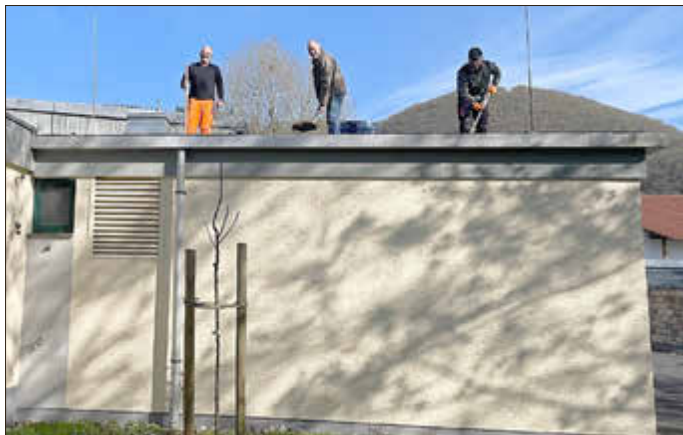
Eine Rentnergruppe befreite das Flachdach der Wiedhalle von Moos und Schlamm. Fotos: Rudolf Boden
