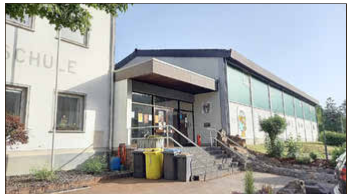
Die Sanierung der zwischen 1976 und 1978 erstellten Sporthalle Nievern ist für das kommende Jahr geplant.
