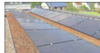
Ein Beispiel für ein neu angelegtes Gründach aus Kottenheim. Foto: Christoph Klink
