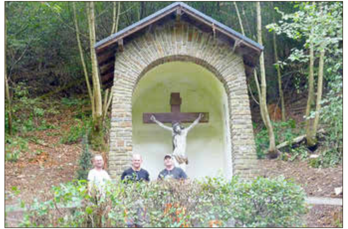
Die Arbeiter des Bauhofes Vallendar am „Höhrer Kreuz“
