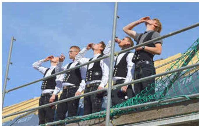
Der Richtspruch wurde hoch oben auf dem Dach vom Zimmermannsteam von Schenk Holzbau begossen. Wenn das kein Glück bringt!
