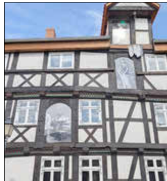
Blick auf die Kunstinstallation und den Zahnlückenfries
