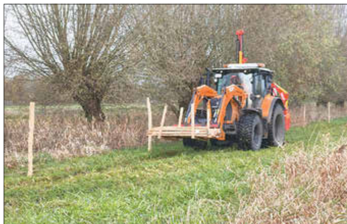
Unternehmen mit Unterstützung des Bauhofes setzen die Pfosten und ziehen die Drähte
