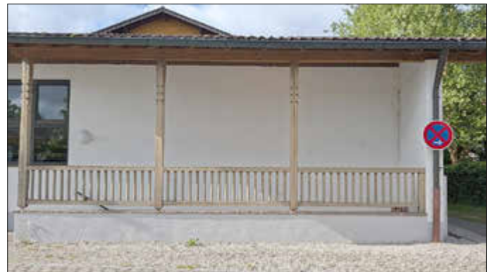
Geplanter Standort der neuen Trafostation: Hinter der Schulturnhalle am Treppenabgang soll künftig die kompakte Station der Bayernwerk Netz AG aufgestellt werden. Foto: A. Caruso
