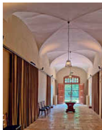
Der renovierte Gewölbeflur
