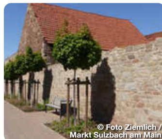
© Foto Ziemlich / Markt Sulzbach am Main
