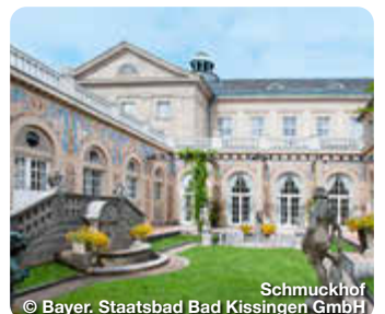
Arkadenbau © Bayer. Staatsbad Bad Kissingen GmbH / Dominik Marx
