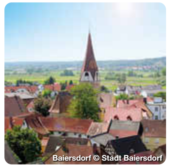
Baierdorf © Stadt Baierdorf
