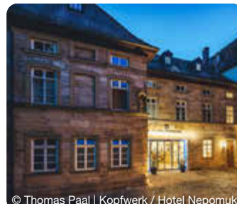
© Thomas Paal | Kopfwerk / Hotel Nepomuk
