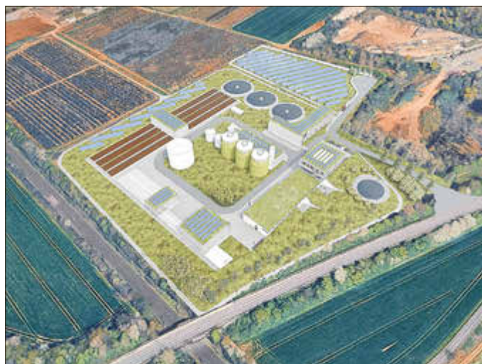
Im Zuge des Wiederaufbaus entsteht in Remagen-Kripp eine hochmoderne neue Kläranlage.
